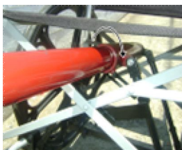
Figura 9. Folga apresentada no acoplamento entre tubo de apoio e barra principal. Alves, J. (2011).
