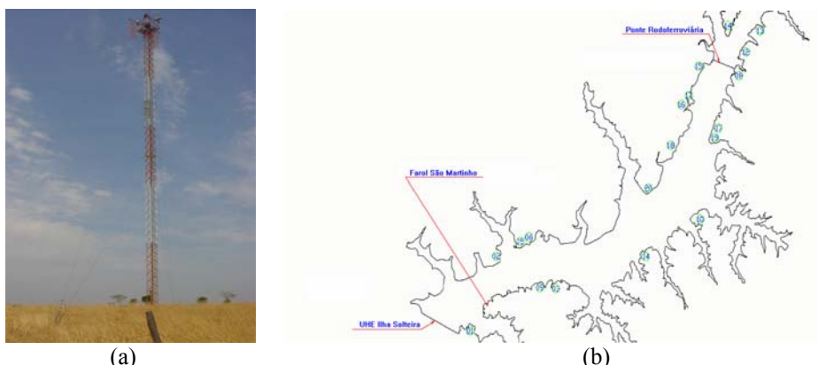
Figura 4. (a) Torre metálica do Farol São Martinho e (b) Posição do Farol e localização de pontos candidatos para a colocação de novos anemômetros
