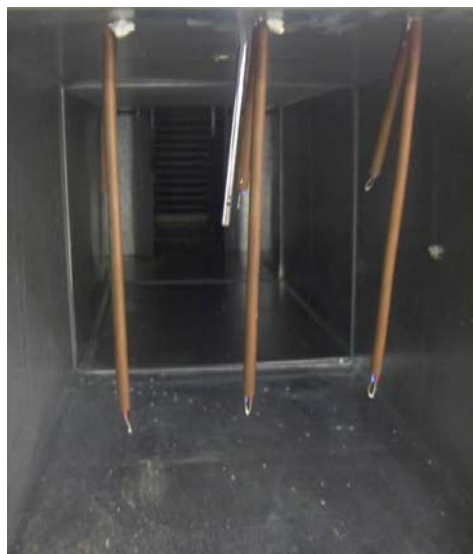
Figura 5. Foto mostrando a fixação dos termopares e higrômetro internamente ao túnel.
