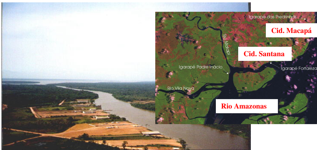
Figura 1: a) Direita acima - Imagem de satélite da zona estuarina estudada; b) Esquerda abaixo - Foto aérea do Distrito Industrial de Santana às margens do Rio Matapi. No detalhe observa-se a foz do Rio Matapi, desaguando no Canal do Norte (Rio Amazonas). Cunha (2000).
