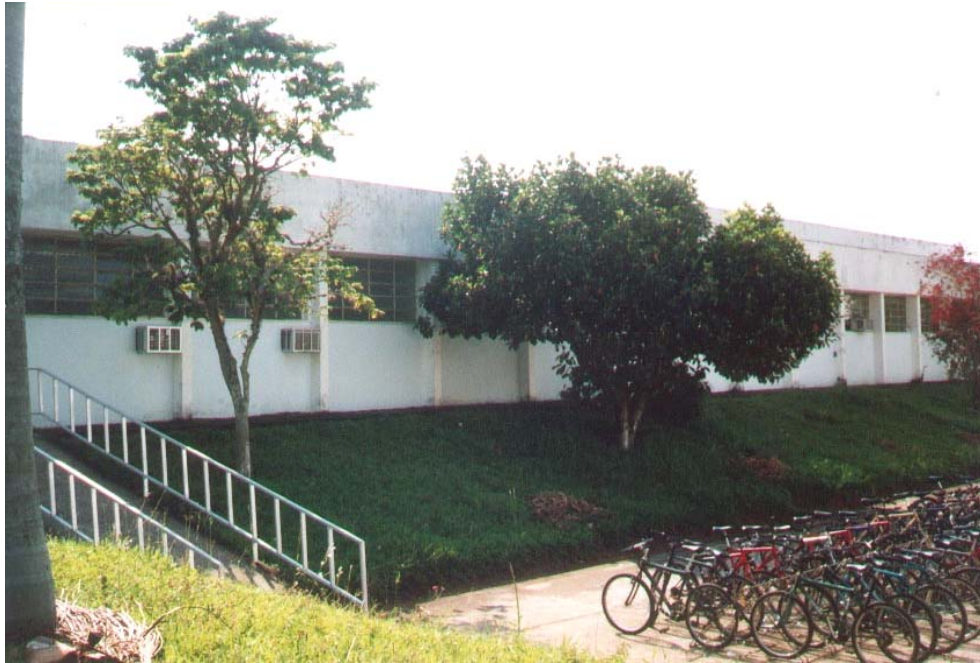
Figura 2. Fachada Sudoeste do Edifício, onde verifica-se a existência de vegetação e condicionadores de ar.
