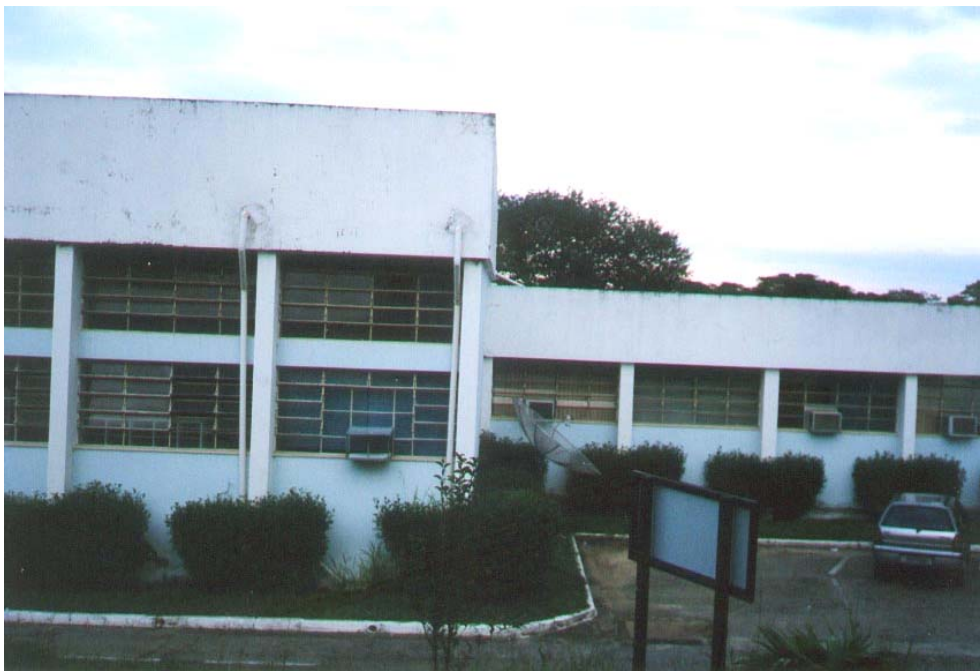
Figura 3. Fachada Nordeste do edifício, onde nota-se a diferença entre o pé-direito da secretaria e dos laboratórios.
