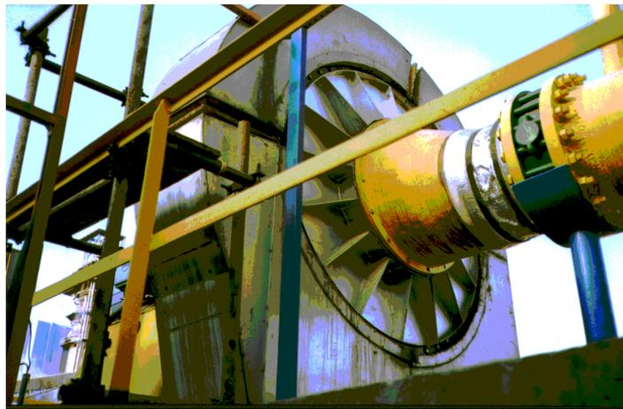
Figura1- Ventilador centrífugo
