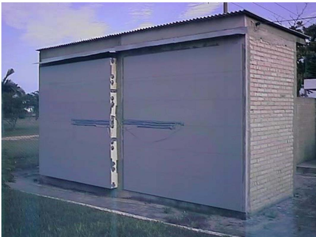
Figura 1 - Vista geral do módulo construtivo com a parede ventilada e a parede comum.
