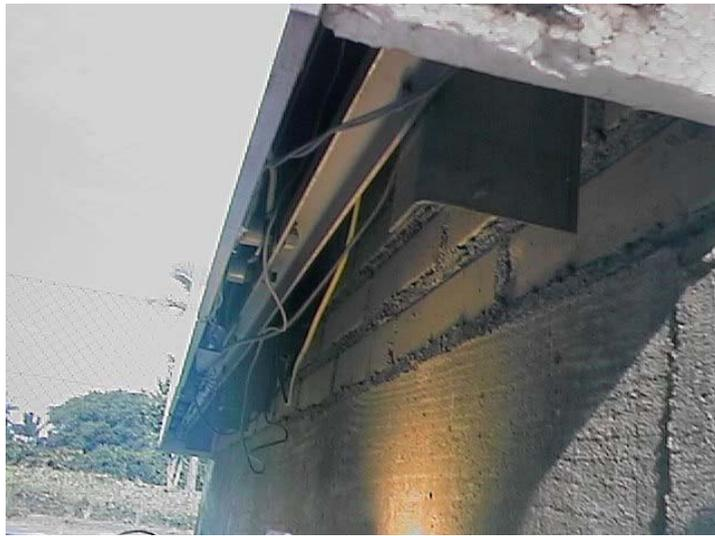
Figura 2 - Detalhe da abertura inferior da câmara de ar ventilada.
