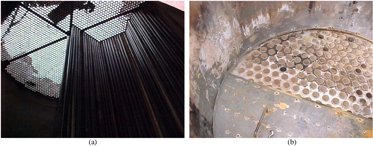
Figura 1. – Fotos de um evaporador de película em manutenção: (a) Vista interna do evaporado, (b) Vista superior do evaporador, mostrando uma parte do alimentador utilizado na formação da película.
