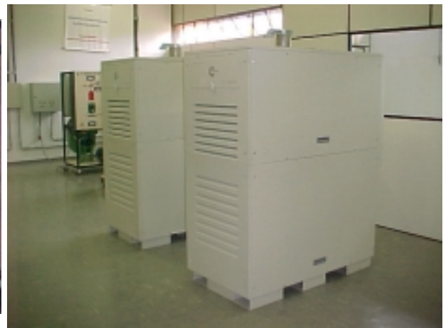
Microturbinas a gás de 30 kW.
