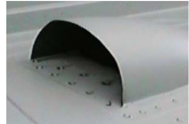
Figura 2 – Entrada de ar tipo “scoop”.
