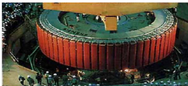
Figura 2. Montagem de rotor de um gerador hidrelétrico.
