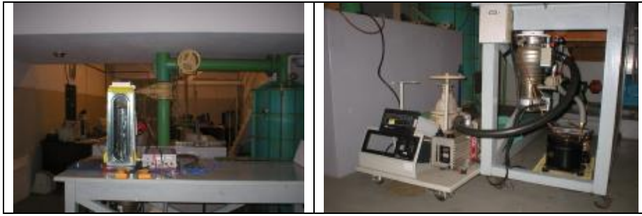
Figura 2. Vista geral, sistema de bombeamento de vácuo e sistema de refrigeração do sumidouro.
