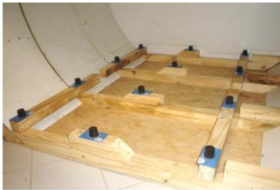
(a) Montagem do sistema de isolamento
