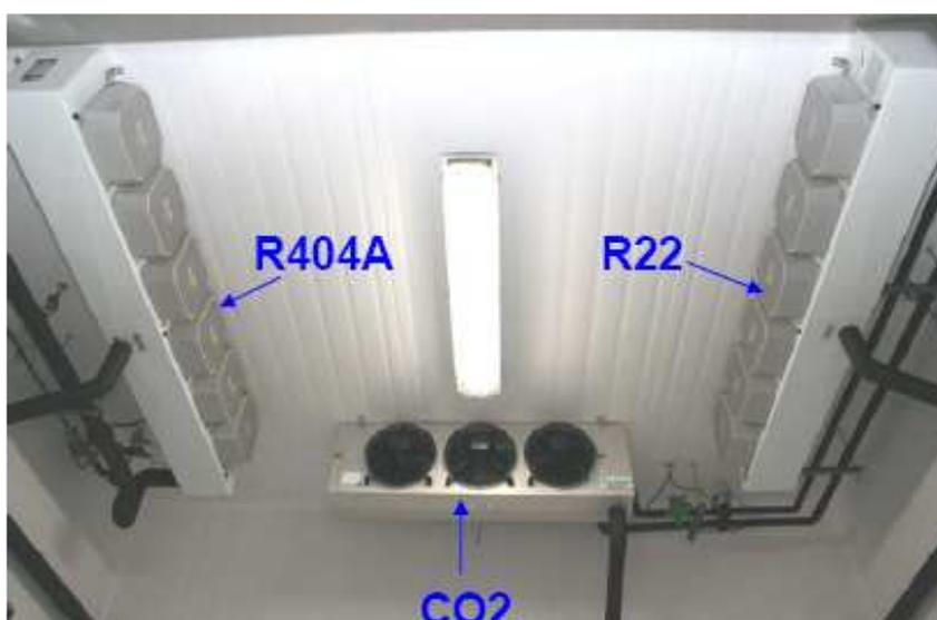
Figura. 06- Evaporadores utilizados (www.bitzer.com.br)
