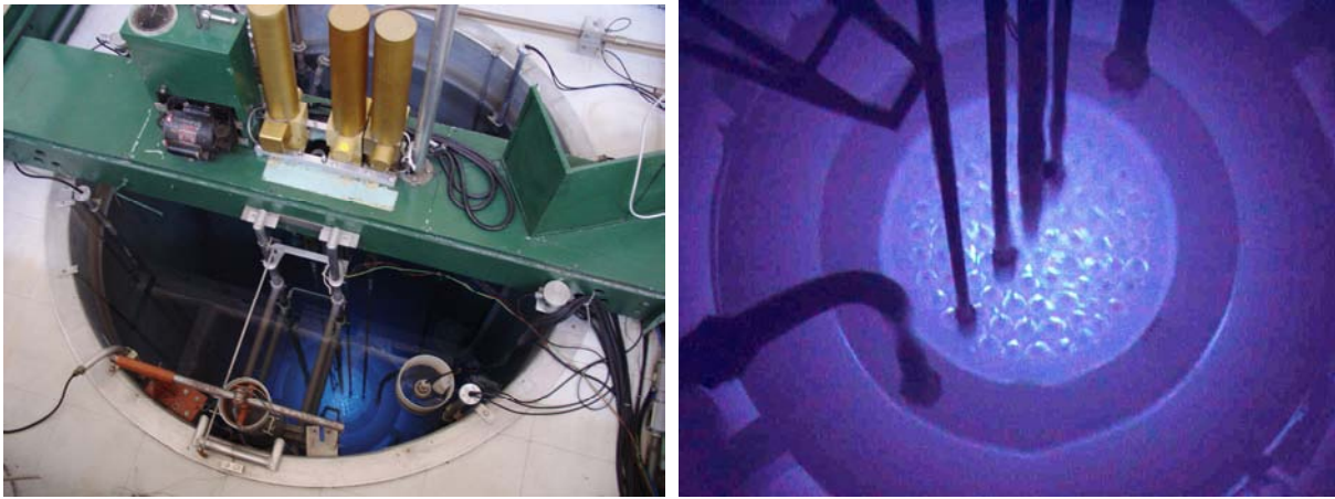
Figura 1. Reator nuclear TRIGA IPR-R1 vista do poço e núcleo com o reator ligado
