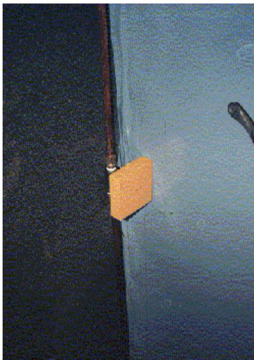
Foto 3 – Anel piezométrico típico no interior de uma câmara de bocais
