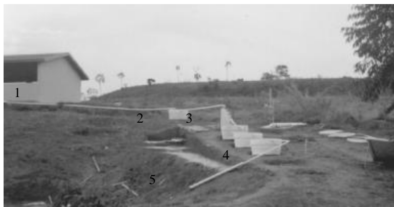
Figura 4 – Vista da suinocultura onde foi instalada a planta piloto do projeto de Godoy Jr (2001) na UNITAU, e onde pretende-se instalar planta em escala real. 1) Suinocultura, 2) Tanque de hidrólise, 3) Série de quatro RAFAs aquecidos por energia solar, 4) Tanques aeróbios, 5) Infiltração no solo.
