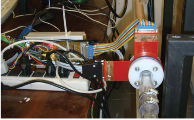
Figura 4: Foto do sensor wire-mesh instalado na seção de testes.
