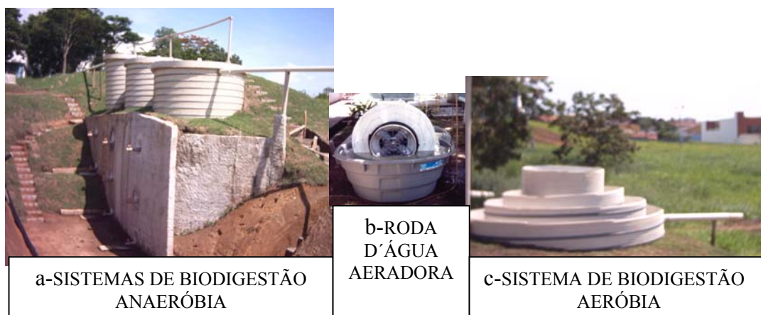
Figura 1 – Configuração da miniETERA e a localização da roda d'água
