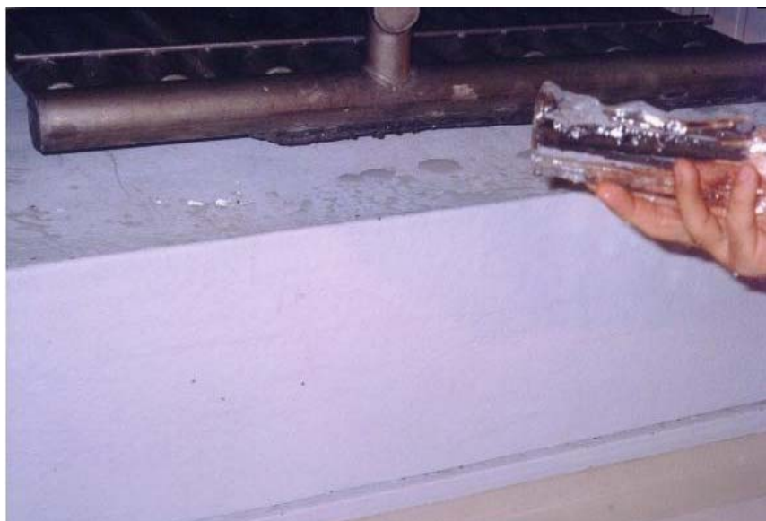
Figura 7. Foto do interior da câmara fria, mostrando parte do gelo que adere à superfície do evaporador.
