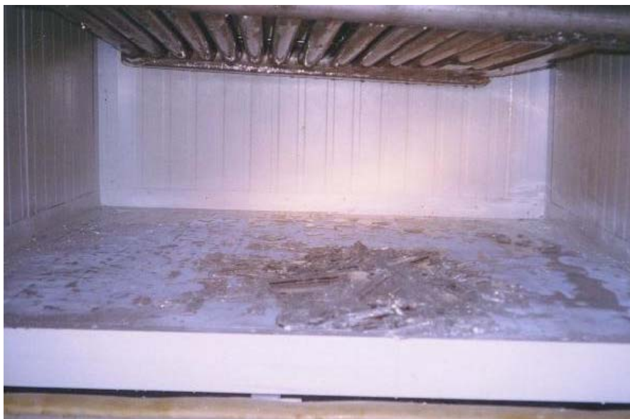
Figura 8. Fragmentos de gelo no interior da câmara frigorífica, sem a caixa de isolante térmico e sem a bandeja.
