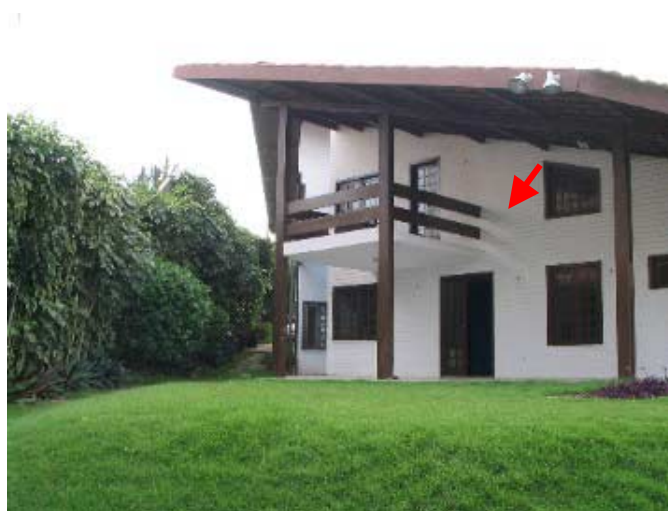
Figura 7. Radiação solar refletida incidindo sobre a parede da varanda.
