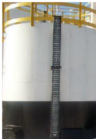
Figura 2. Tanque com medição de nível por régua externa, resolução 50 mm, Santos (2003).
