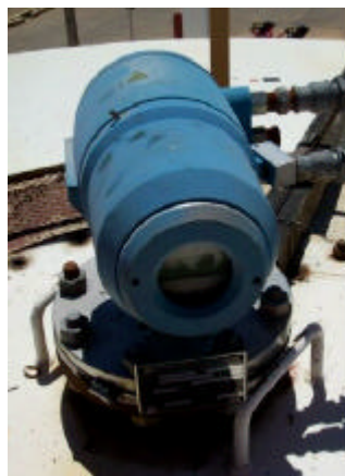
Figura 3. Tanque com medição de nível por radar.
