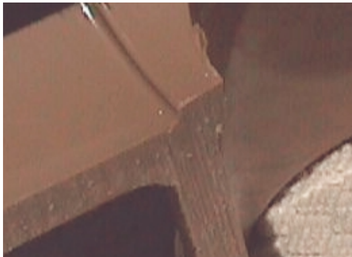
Figura 6. Região de concentração de tensão - parte interna
