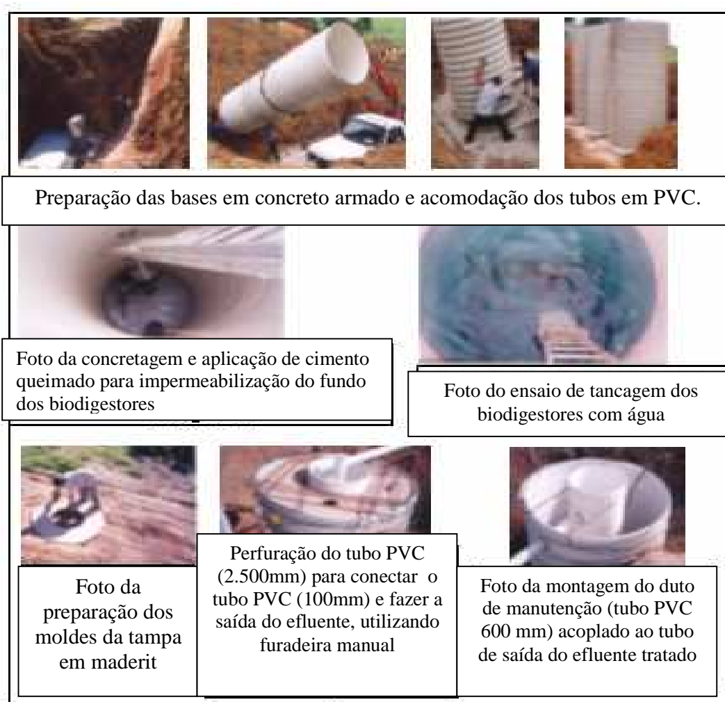
Figura 6. Seqüência de fotos da acomodação dos tubos, da vedação do fundo dos biodigestores, do ensaio de tancagem e da preparação da campânula.
