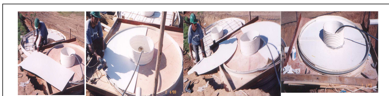
Figura 7. Seqüência de fotos do corte das chapas em PVC, sua montagem e colagem nos tubos de PVC tipo Rib Loc.
