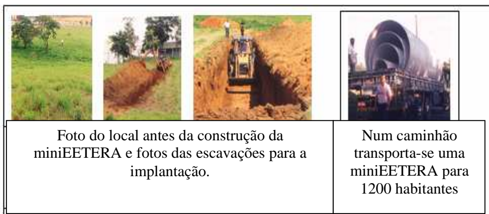
Figura 5. Seqüência de fotos da preparação do terreno e chegada dos tubos em PVC.
