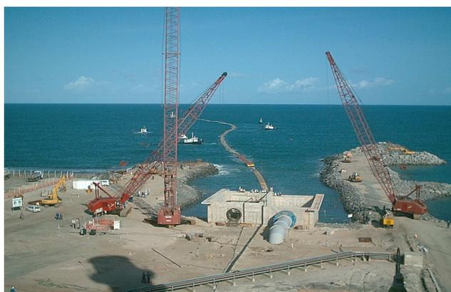
Figura 9. Aproximação do emissário junto ao tanque de acomodação.
