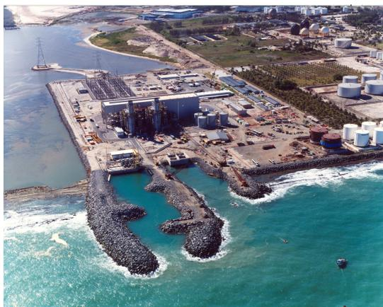
Figura 4. Canal de Captação aberto e o de descarte ainda sem o aterro, durante a fase de instalação dos emissários (foto em outubro/2003).
