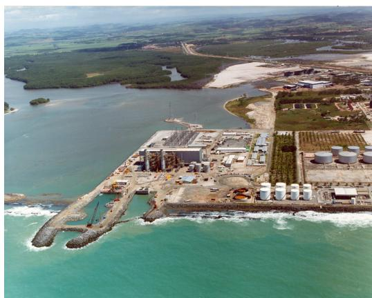
Figura 3. Canal de Captação ainda fechado e o de descarte ainda por ser aterrado após a instalação completa dos emissários (foto em agosto/2003).
