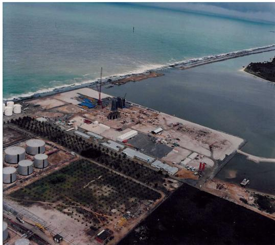
Figura 1. Condição das obras da UTE em agosto/2002. Destaque para as obras da Tomada D'água ainda não iniciadas.
