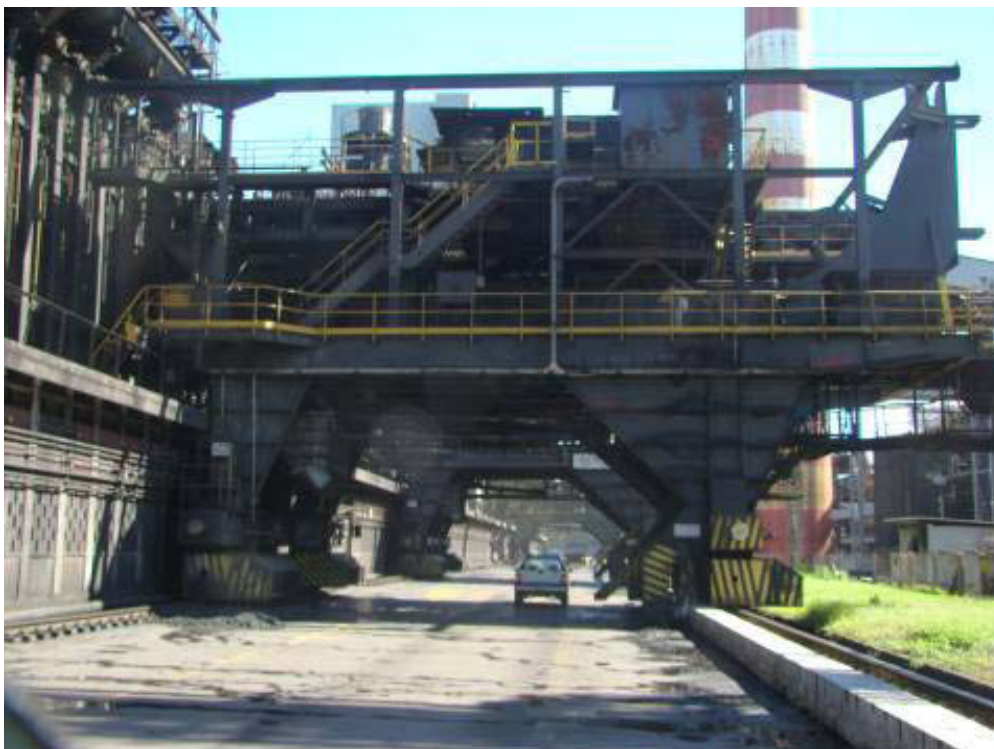
Figura 1. Máquina Desenformadora de Coque.
