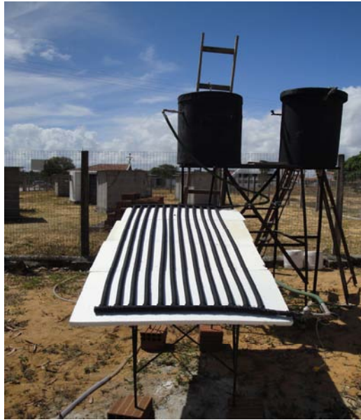
Figura 1. Sistema solar alternativo de aquecimento de água em funcionamento na configuração III.
