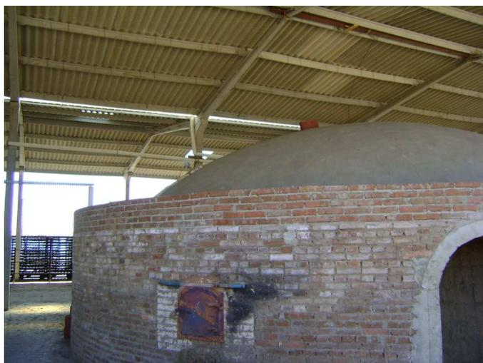
Figura 2. Forno tipo abóbada
