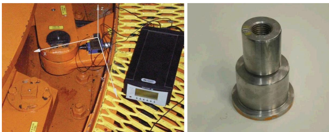
Figura 6. Foto da montagem do acelerômetro na manivela e foto de um pino de cisalhamento que une a biela à manivela.
