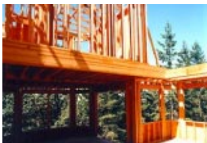
Figura 3. Aplicação do Glulam na construção de residências.
