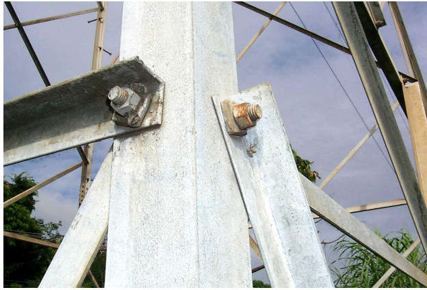
Figura 1. Detalhes da fixação das cantoneiras na construção da torre.
